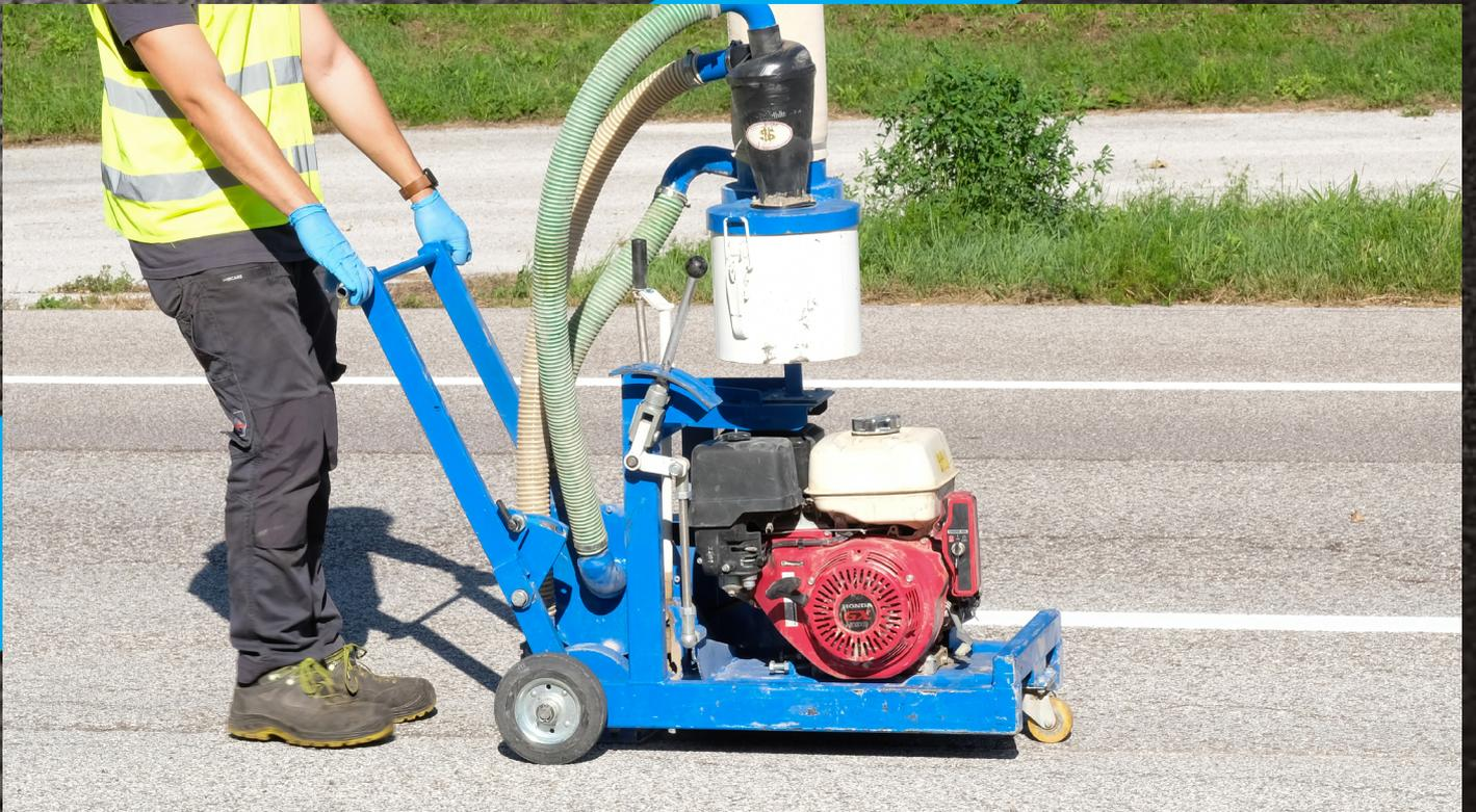
La preparazione della superficie da sigillare è estremamente importante per la buona riuscita della sigillatura. Nel caso in cui la fessura abbia una larghezza inferiore a 1 cm è opportuno effettuare il suo allargamento con una fresa particolare, grazie alla quale è possibile creare un canale che consente al sigillante di chiudere adeguatamente la fessura. La fresa, inoltre, è fornita di un meccanismo che aspira il materiale e la polvere che si formano durante la fresatura.
