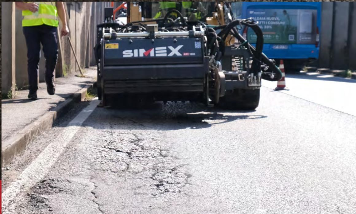
Nach kurzem angleichen kann die Fahrbahn sofort mit einer Walze oder Rüttelplatte verdichtet und unverzüglich für den Verkehr freigegeben werden.
